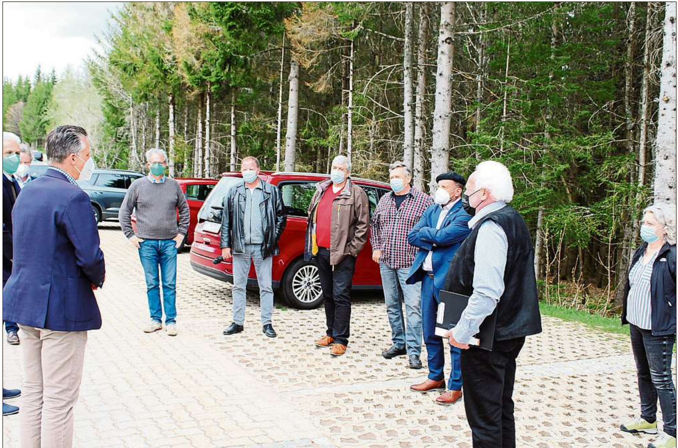
Thorsten Frei (im Vordergrund links) freut sich über das Interesse, dem er an der Baustelle am OHG begegnet.
