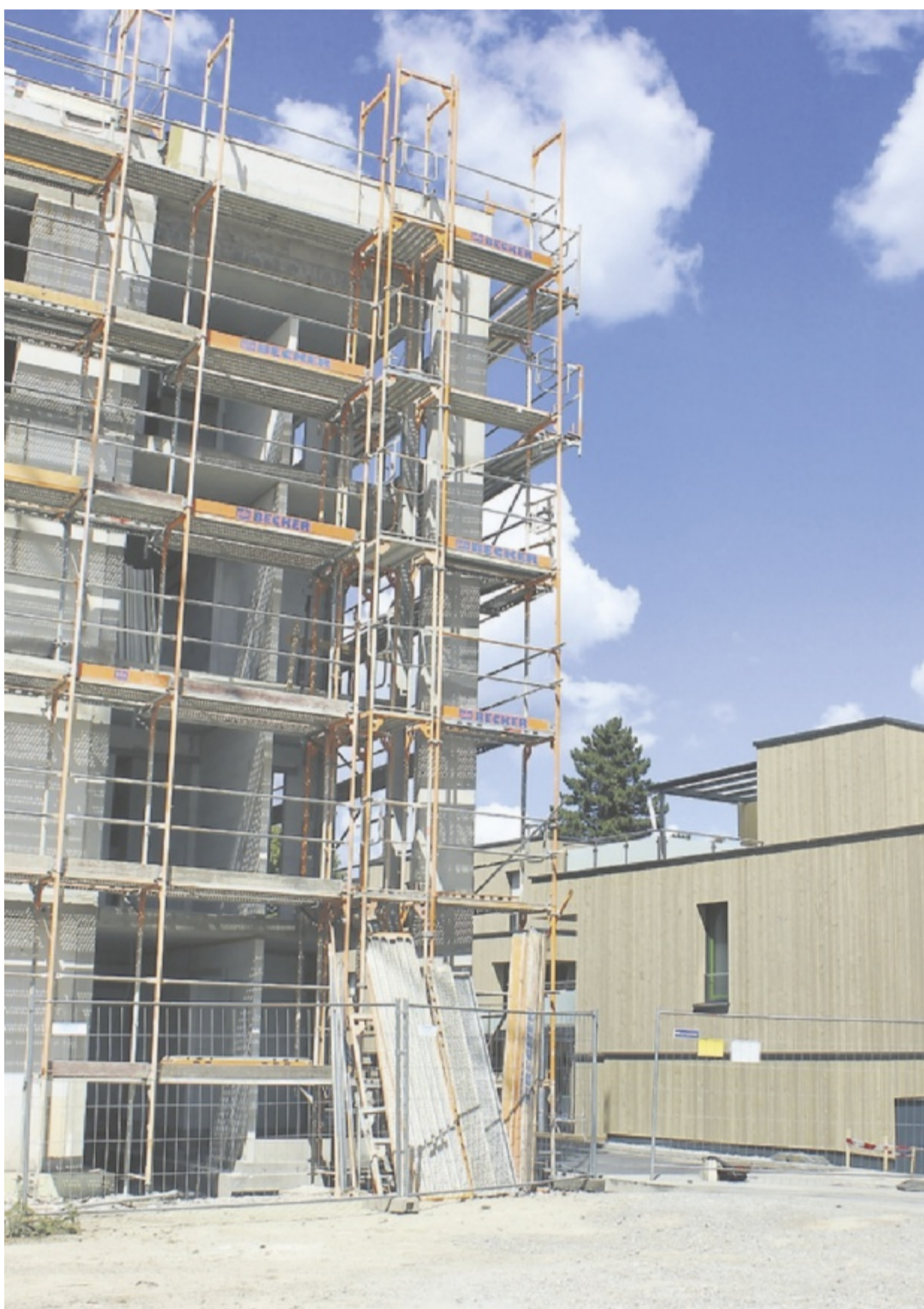
Am Neubau der Familienheim-Baugenossenschaft im Luisen-Quartier in Villingen wird weiter gearbeitet. Für Folgeprojekte stehen die Chancen aber derzeit schlecht. Fotos: Daniela Schneider
