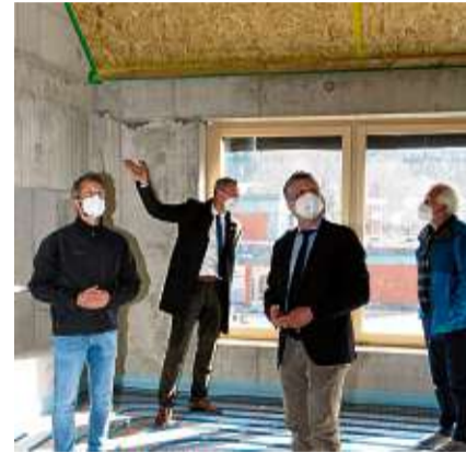
Da staunt Bundestagsabgeordneter, Thorsten Frei (vorne) nicht schlecht. Ortsbaumeister Patrick Lutz (links) erklärt den Baufortschritt am Überaucher Dorfhaus
