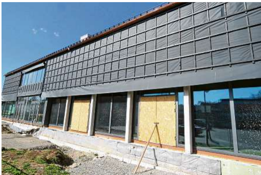
Dorfhaus Überauchen: Noch in diesem Jahr soll es eingeweiht werden. Derzeit sind die Arbeiten an der Außenfassade aber ins Stocken geraten. Das dafür benötigte Holz konnte
