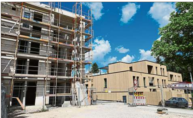
85 zum Teil öffentlich geförderte Mietwohnungen entstehen unter der Regie der Baugenossenschaft Familienheim gerade in der Vöhrenbacher Straße.
