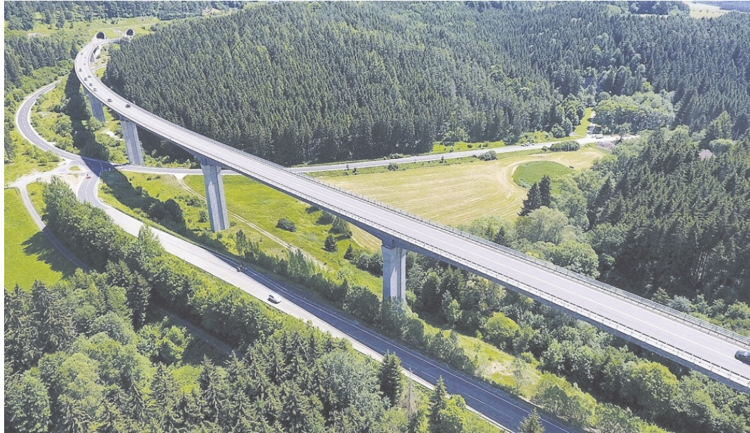
Dieses Foto aus einer Mitteilung des Regierungspräsidiums Freiburg vom vergangenen Dezember zeigt die Gauchachtalbrücke bei Döggingen von oben. Geplant ist hier schon seit vielen Jahren noch eine zweite Brücke. Der Verkehrsclub Deutschland hat dagegen geklagt. Foto: Lukas Hildebrand - stock.adobe.com
