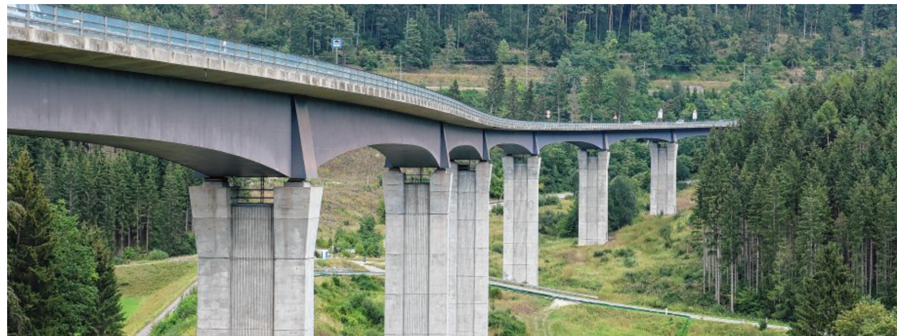
Die Gauchachtalbrücke der Bundesstraße 31 bei Döggingen und Unadingen. Direkt daneben soll eine zweite, gleich aussehende Brücke entstehen. Ein Antrag des Verkehrsclubs Deutschland (VCD) auf Aufhebung der Plangenehmigung hatte das Projekt gestoppt, nun soll es weitergehen. BILD: JENS WURSTHORN
