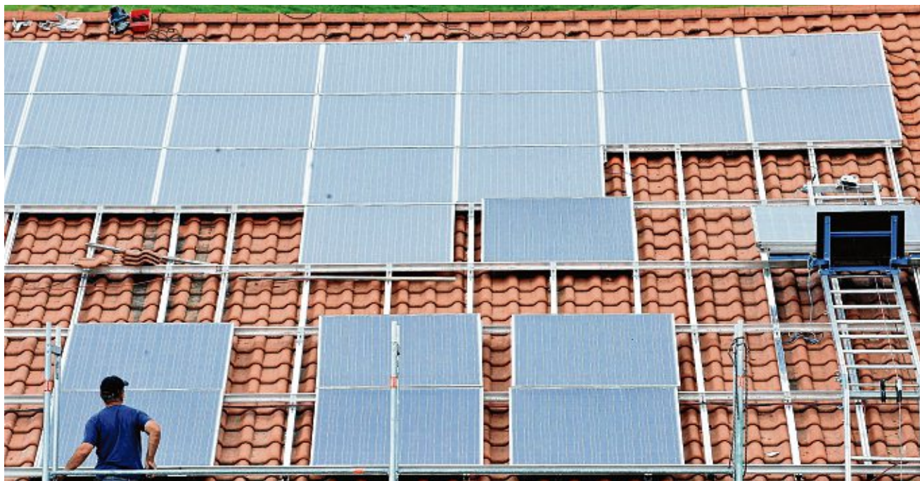
Ein Arbeiter installiert auf einem Dach eine Solaranlage. Die Union will den Ausbau von Solar- und Windenergie vereinfachen. BILD: DPA
