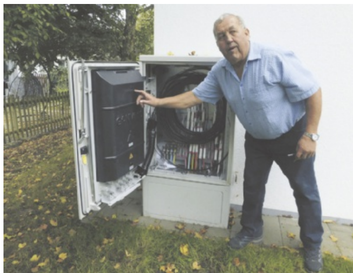
Foto links: Franz Honold, Bauleiter bei der Firma Georg Vetter aus Hüfingen, zeigt einen Schaltkasten für Glasfaser in Achdorf. Foto rechts: Franz Honold zeigt Technik, mit der Glasfaser bis zu den Häusern in die Leerrohre eingeblasen wird. Fotos: Eric Zerm
