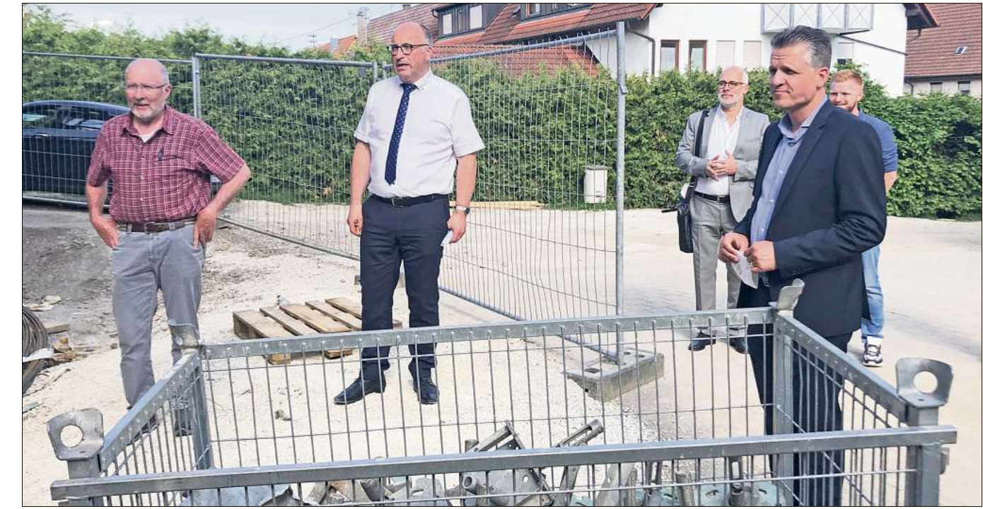
Mehrere Gemeinderäte, darunter Hans Mauch (von links), Bürgermeister Ralf Pahlow und Eckhard Britsch besichtigen mit dem Bundestagsabgeordneten Thorsten Frei (von links) die Baustelle Marielehaus.
