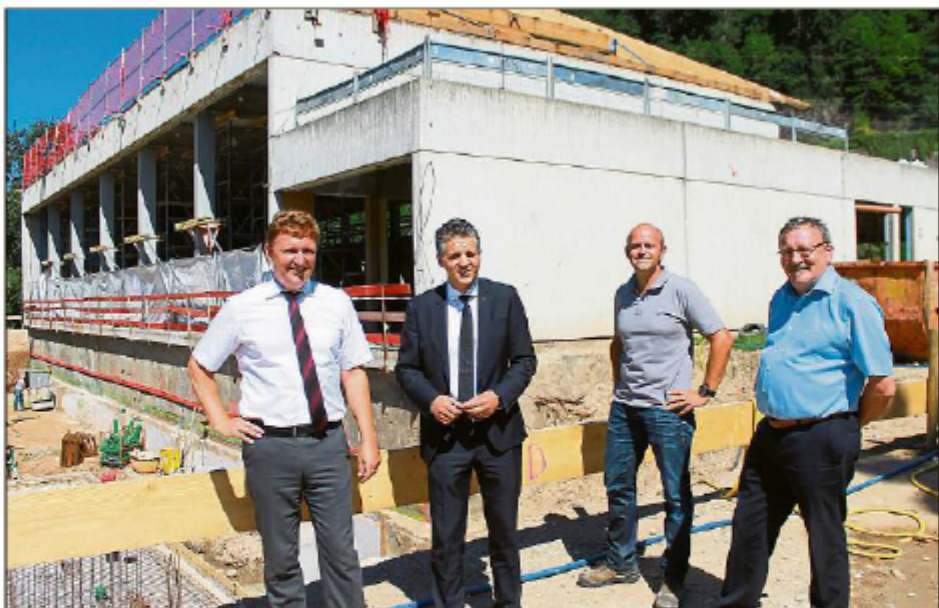
Bürgermeister Wolfgang Herrmann (von links) informierte Thorsten Frei zusammen mit Michael Hug und Hermann-Josef Keller über den aktuellen Stand auf der Baustelle des Kinzigtalbads. Foto: Störr
