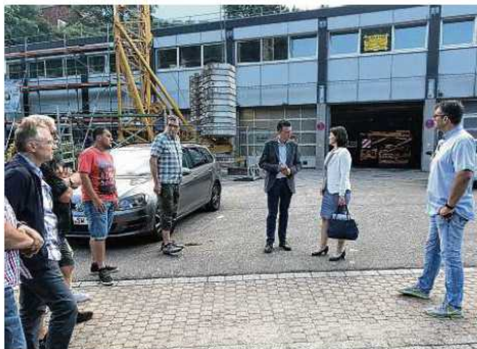
Bundestagsabgeordneter Thorsten Frei besichtigt zusammen mit der Bürgermeisterin Lisa Wolber und den Gemeinderäten die Baustelle zur Sanierung der Mehrzweckhalle.
